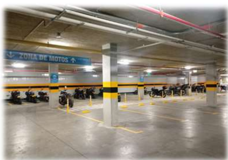
Zona exclusiva para el parqueo de motos en sótano 2
